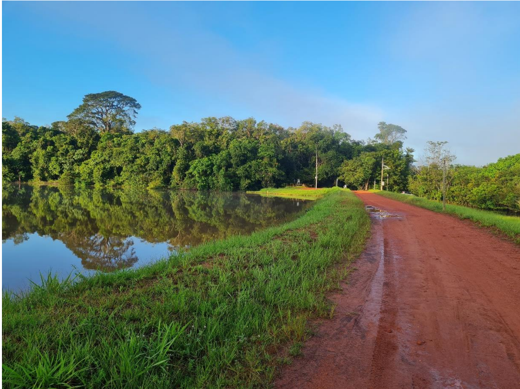
Figura 4-2: Reservatório da Barragem Água Fria (Fonte: Visita Técnica, WALM, 29/05/2023).
