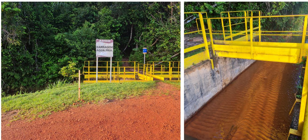
Figura 4-4: Sistema extravasor da Barragem Água Fria (Fonte: Visita Técnica, WALM, 29/05/2023).
