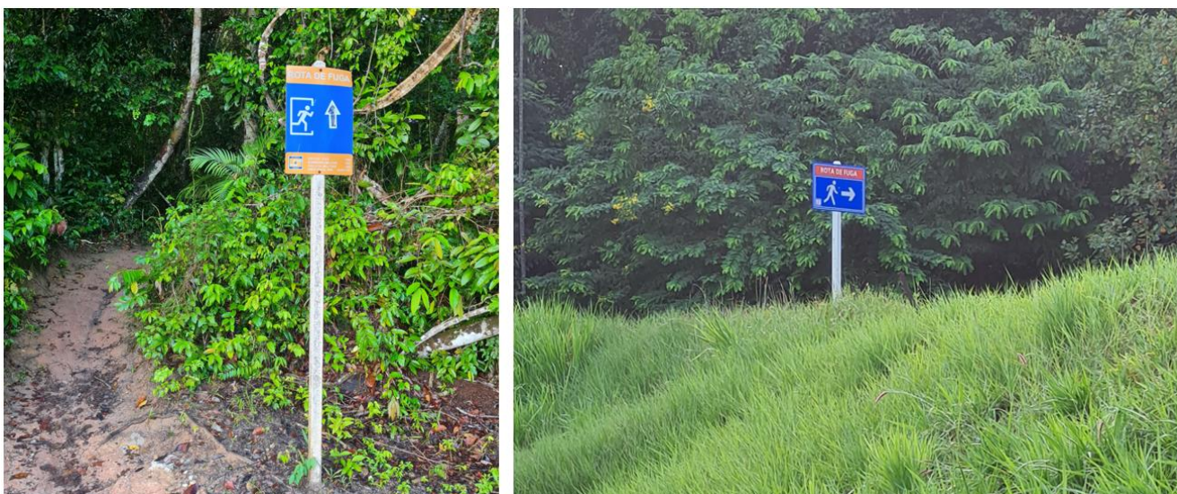
Figura 4-5: Placas de rota de fuga localizadas na ombreira esquerda e ombreira direita, respectivamente (Fonte: Visita Técnica, WALM, 29/05/2023).
