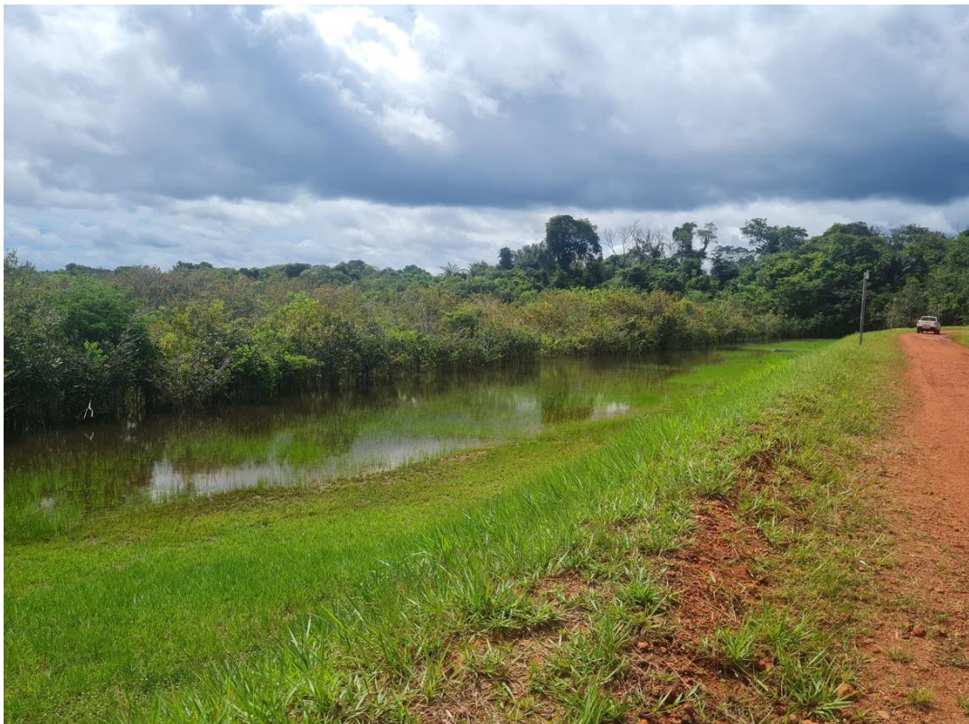
Figura 4-3: Região de jusante da Barragem Água Fria (Fonte: Visita Técnica, WALM, 29/05/2023).
