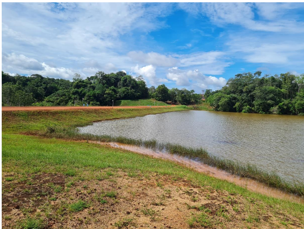
Figura 4-6: Reservatório da Barragem A1 (Fonte: Visita Técnica, WALM, 29/05/2023).
