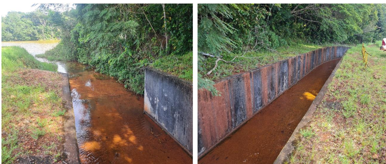
Figura 4-8: Sistema extravasor da Barragem A1 (Fonte: Visita Técnica, WALM, 29/05/2023).
