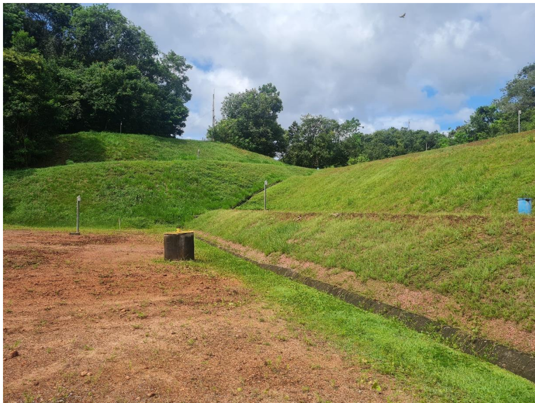
Figura 4-7: Talude de jusante da Barragem A1 (Fonte: Visita Técnica, WALM, 29/05/2023).
